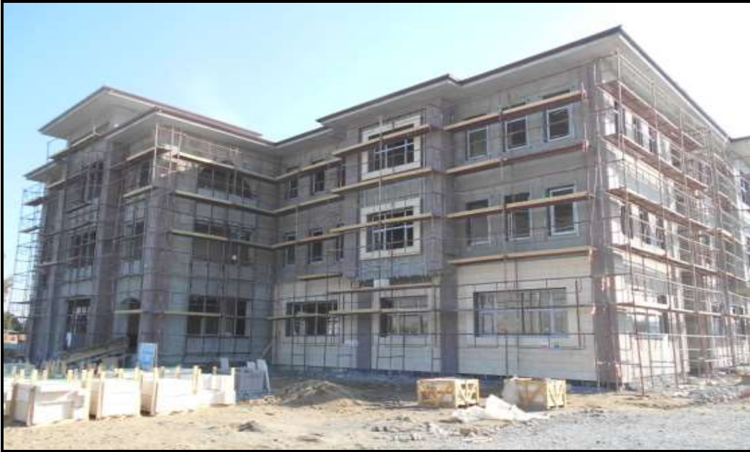
Şekil 117. Yamantürk Meslek Yüksek Okulu İnşaat Çalışmaları, Ocak 2017
