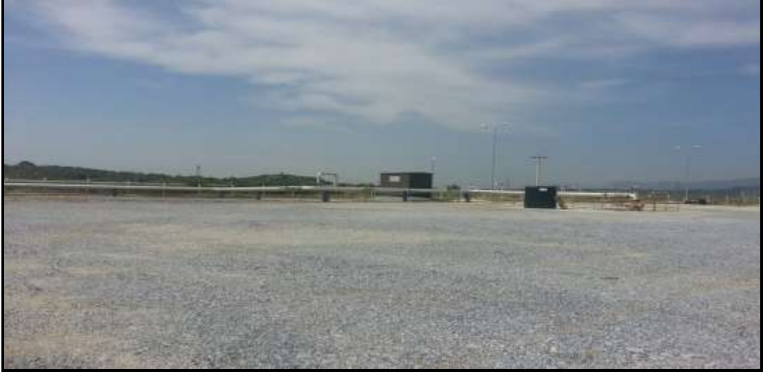
Şekil 77. Planlanan Proje Alanına Ait Genel Görünüm-245 ada 147 parsel
