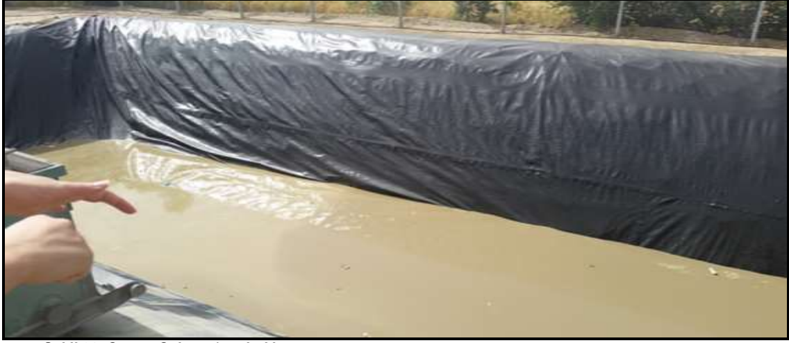
Şekil 93. Çamur Çukuru (mud-pit)
