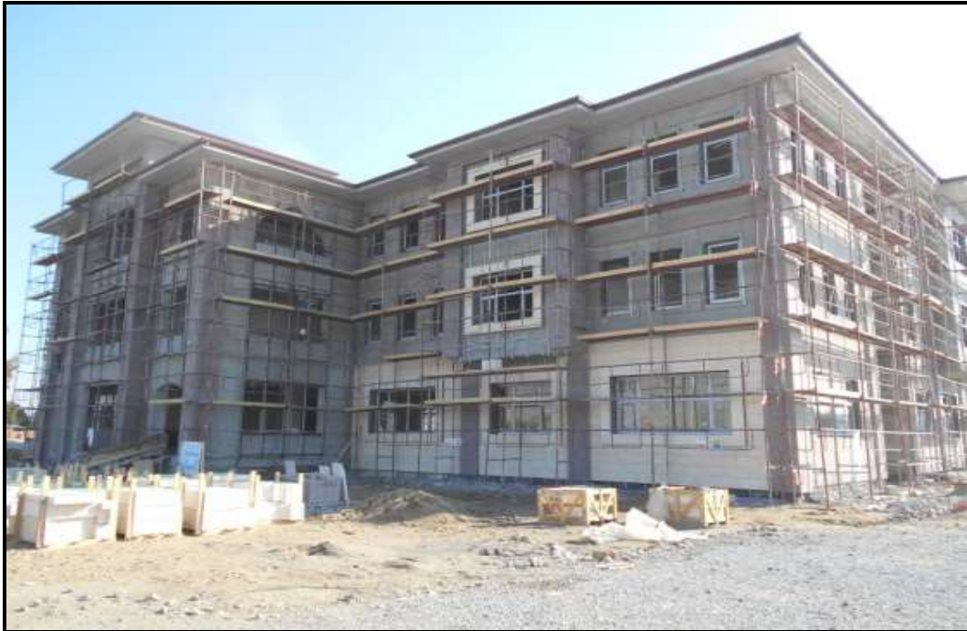
Şekil 117. Yamantürk Meslek Yüksek Okulu İnşaat Çalışmaları, Ocak 2017
